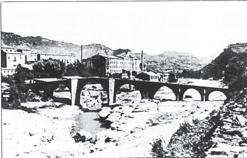
Vista lateral del pont sobre el riu llobregat, a Vilomara. (Fotografia: Arxiu F. Villegas)
