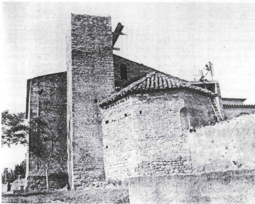
Fotogr. Església de Sta. Maria de Rocafort
